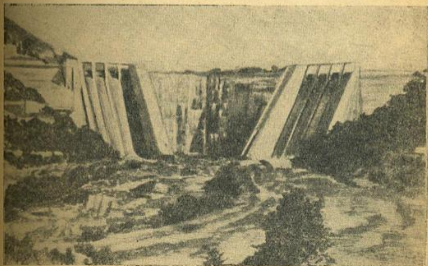
Рис. 72. Береговые водосливы арочной плотины
