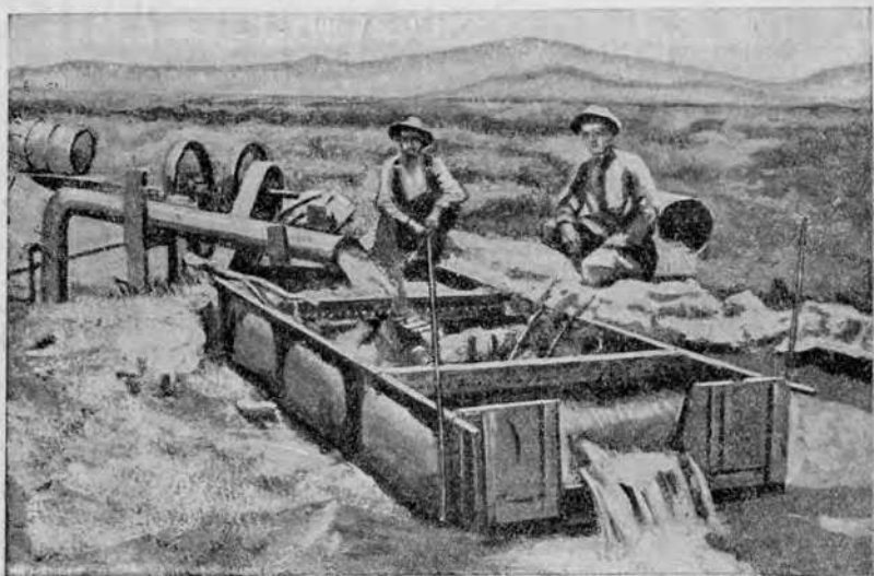
Рис. 48б. Складной водомер (по Мейнцеру и Кельтону).
