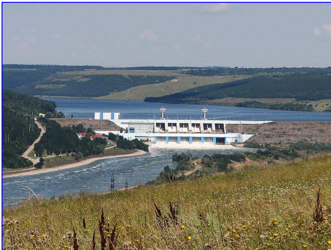
Рис. 1. Плотина Днестровской ГЭС-1
