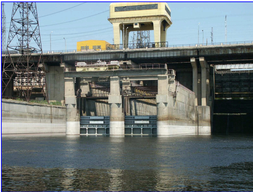
Рыбоподъемник Волжской ГЭС
