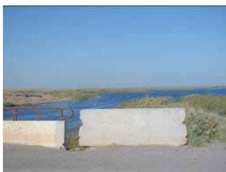
Рис. 3.3 Центральный Голодностепский коллектор (ЦГК)
