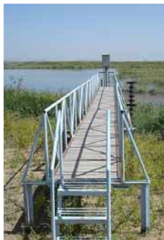
Рис. 4.2. Гидрометрический мостик
