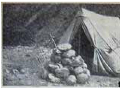
Фото 1. Пирамидка (тур) над репером (окрашенный эмалевой краской валун, от которого велась нивелировка).
