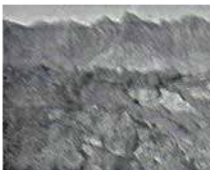
Фото 14. Поверхность завала в центральной части. На поверхности камней сереет пыль, оставшаяся со времени происшедшего обвала (с 1911 г.).
