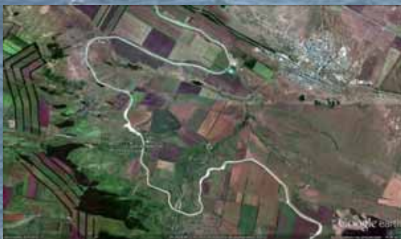
Участок моностропного канала БСК-4, ПКЗН (район Ежовитинского распределителя)
