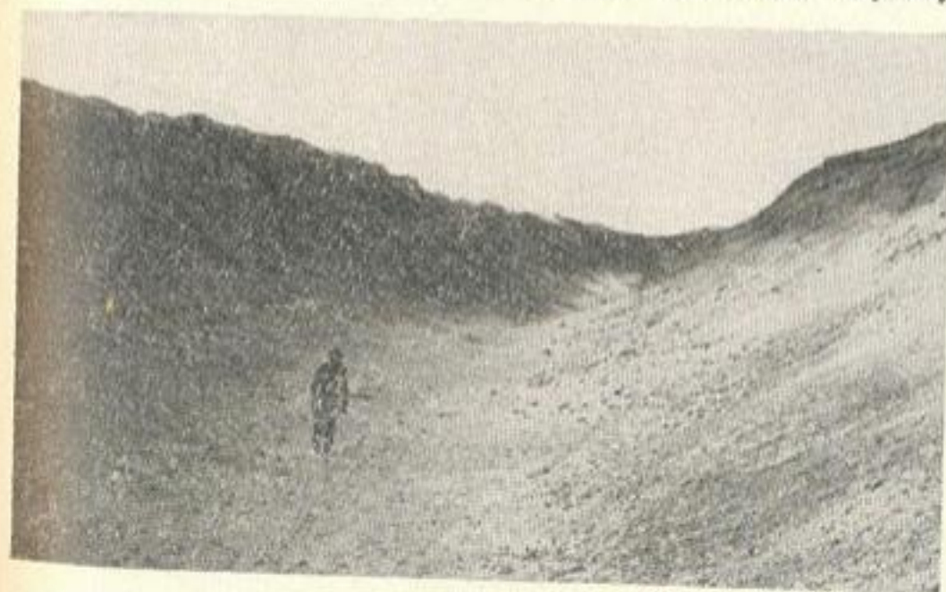
Рис. 27 Участок Каракумского канала, полученный взрывным способом.
