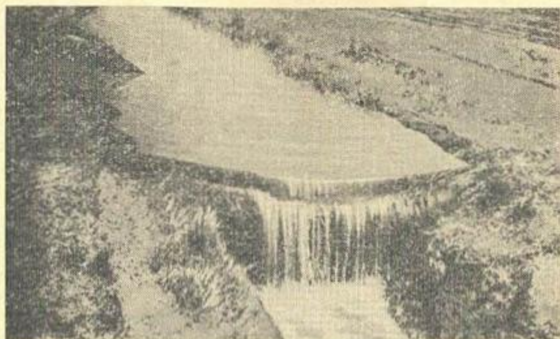
Рис. 7. Гибкая переносная перемычка из капроновой ткани и сифон, подающий воду в гибкий трубопровод.
