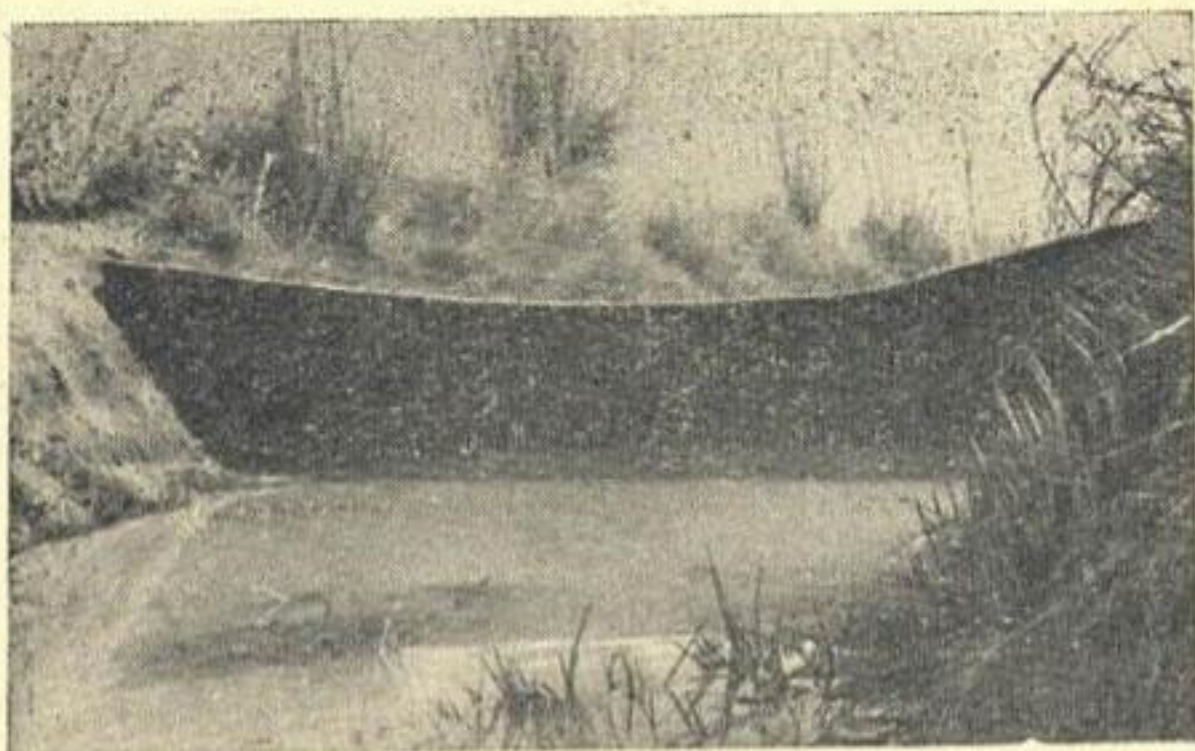
Рис. 56. Гибкая перемычка шириной 8 м на водоотводящем канале; вид со стороны нижнего бьефа.
