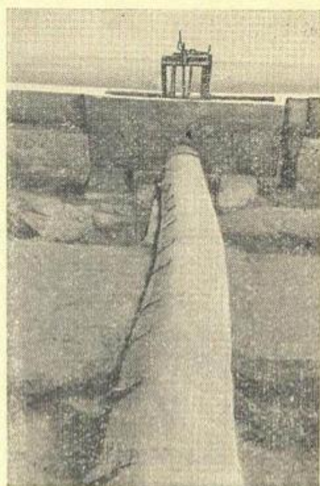
Рис. 16. Гибкий трубопровод диаметром 400 мм, подключенный к гидранту лотка.
