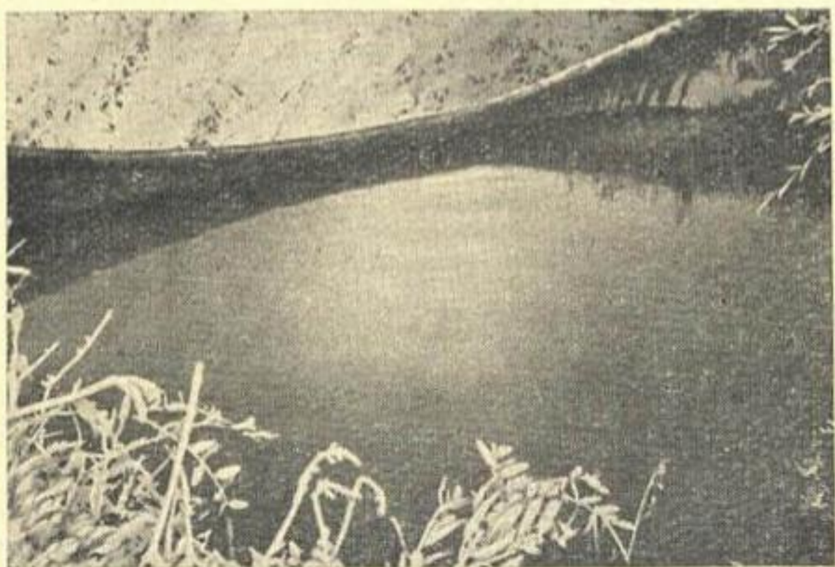
Рис. 57. Гибкая перемычка, перекрывающая водоотводящий канал; вид со стороны верхнего бьефа.
