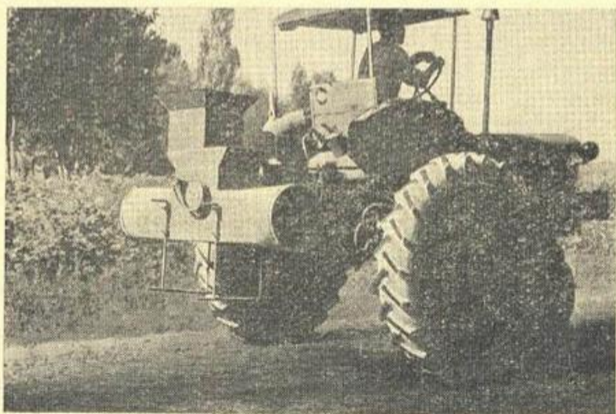
Рис. 64. Питатель-смеситель перемещается с одной позиции на другую с помощью навесной гидросистемы трактора.
