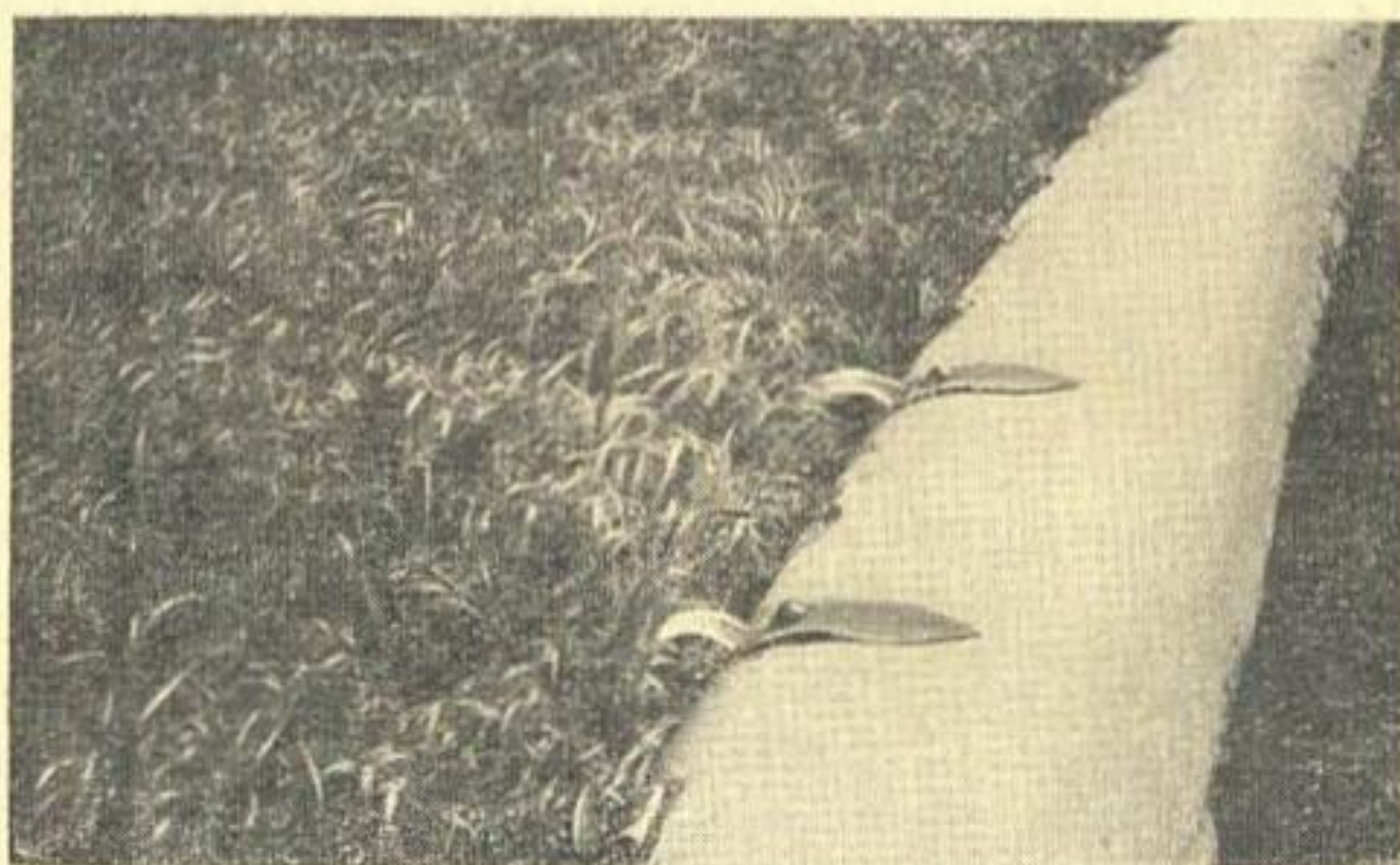
Рис. 54. Гибкий трубопровод диаметром 460 мм с водовыпусками диаметром 40 мм.
