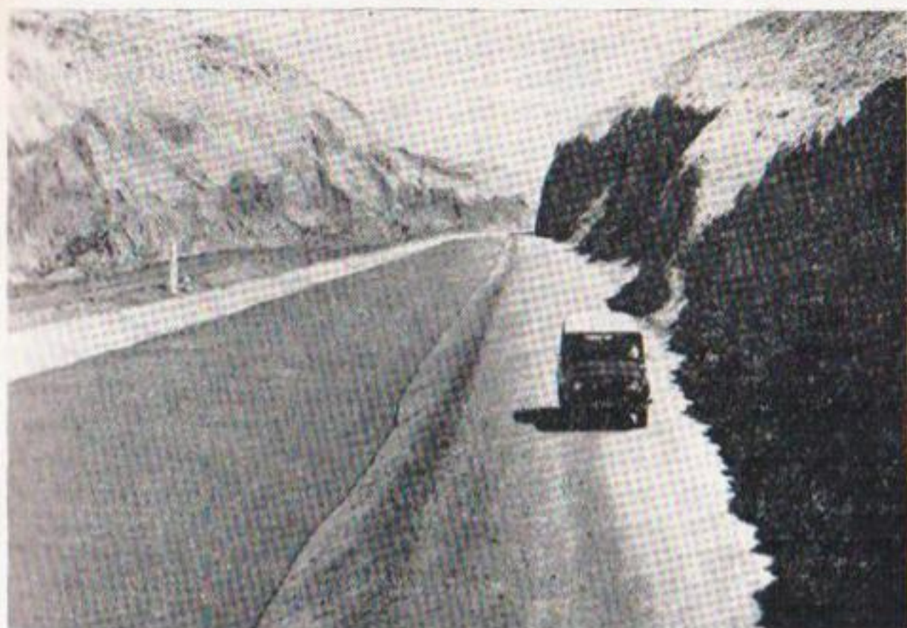
Р и с. 3. Бетонированный канал.
