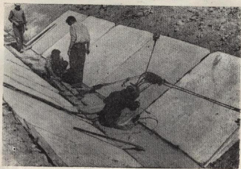
Рис. 16. Стягивание плит силовыми цилиндрами на канале 5-1-Х.
