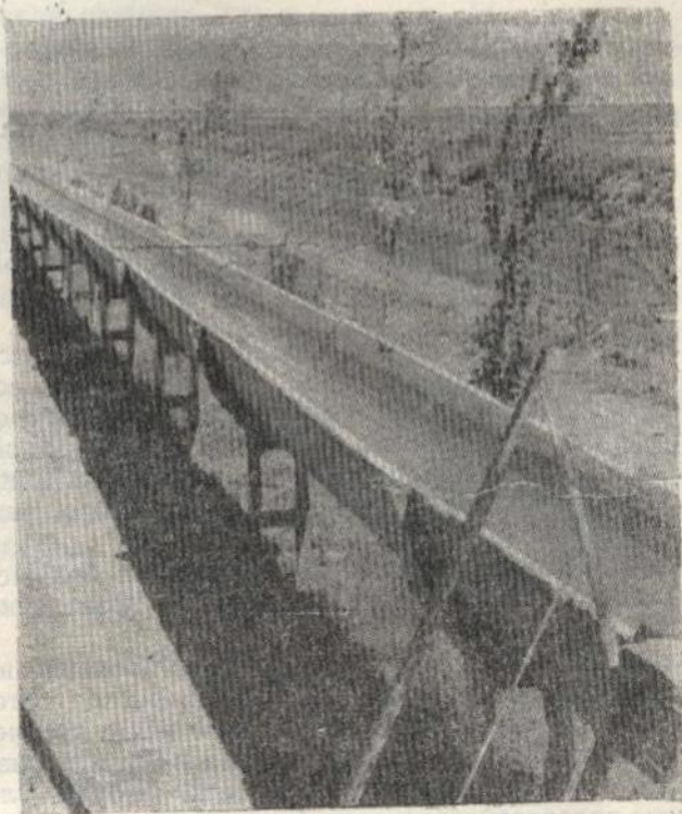
Рис. 1. Действующий лотковый канал 5-III-X в совхозе им. Ю. А. Гагарина (на переднем плане металлический служебный мостик).
