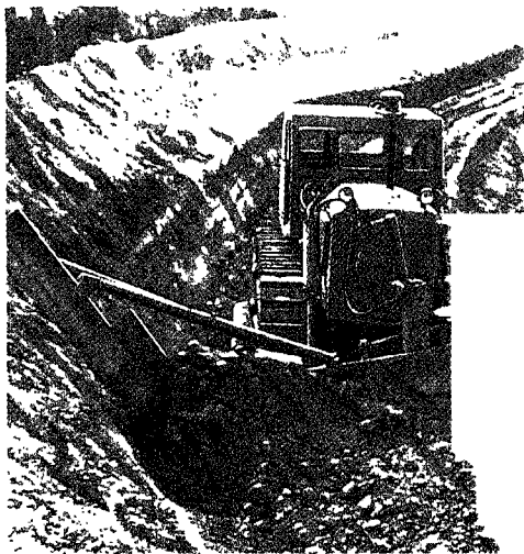
Строительство террас буль- дозером с откосником
