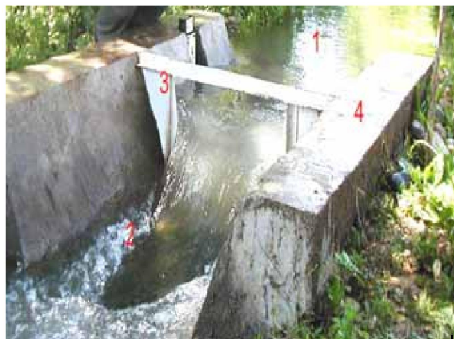
Рис. 3.2. Водослив Чиполетти (вид с нижнего бьефа): 1- подводный участок; 2-отводящий участок; 3-водослив; 4-успокоительная ниша с рейкой;
