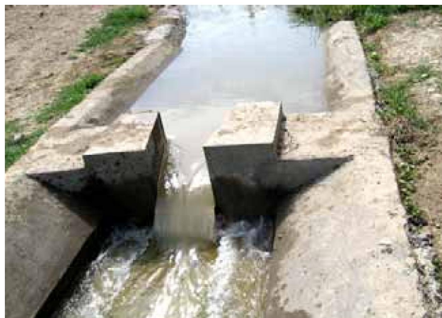
Рис. 3.4 Водомерный лоток САНИИРИ, отводящая часть 1 – дно лотка, 2 –выходные открылки, 3 – водобойный колодец, 4 – крепление откосов отводящей части канала
