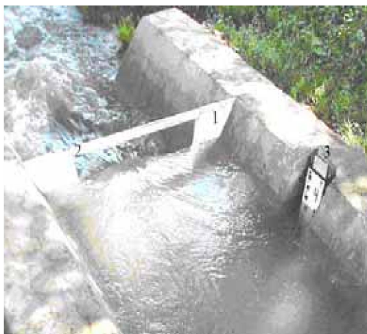
Рис. 3.1. Водослив Чиполетти (вид с верхнего бьефа):
