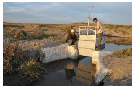
Использование восстановленной оросительной системы для влагозарядкового полива *
