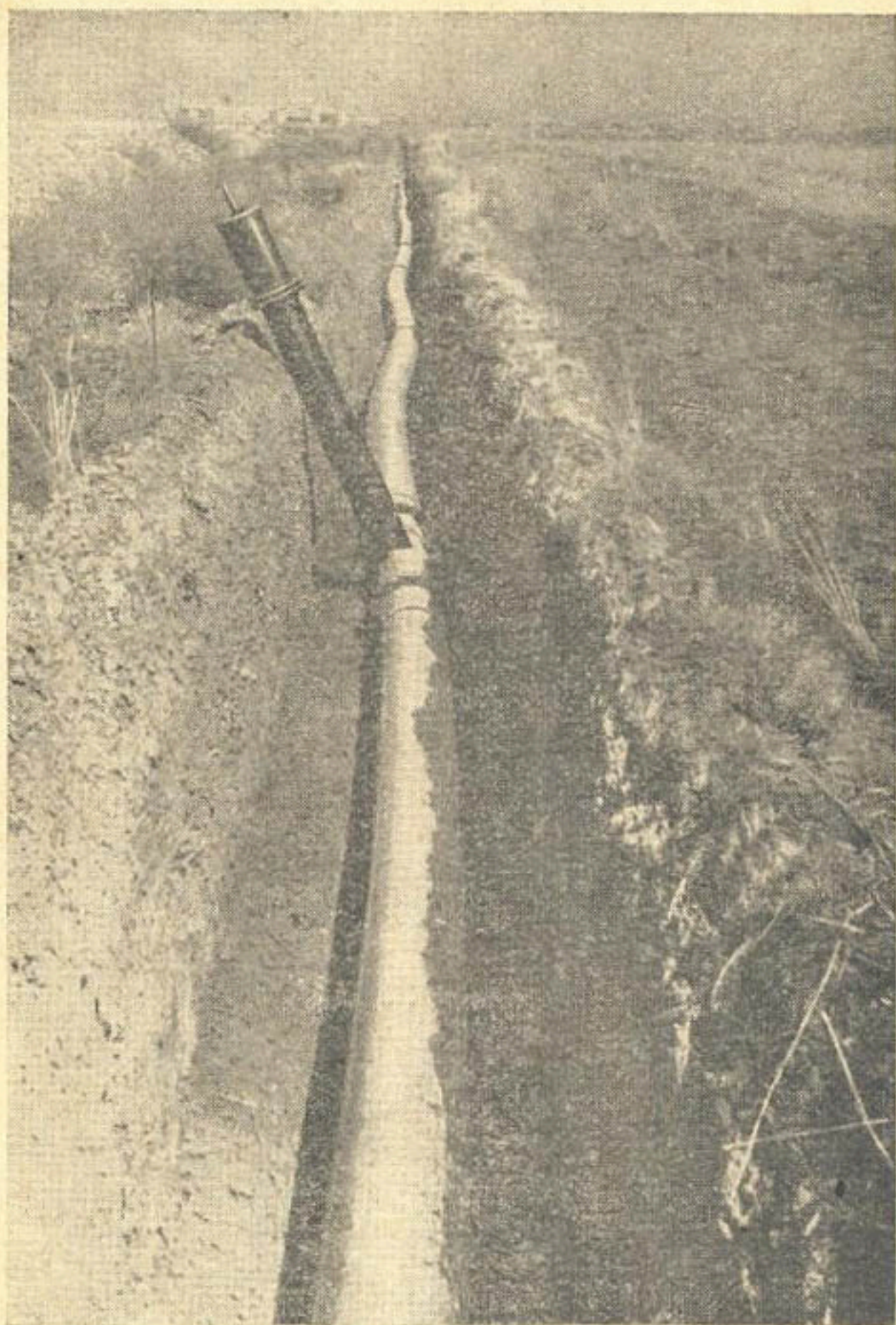
Рис. 25. Самотечно-напорный полиэтиленовый трубопровод диаметром 300 мм, уложенный в траншею (Таджикская часть Голодной степи, зона командования канала ТМ-2).
