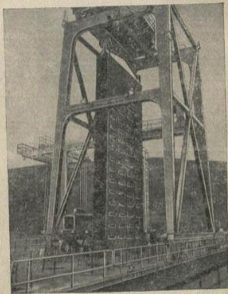
Рис. 8. Густая решетка для гашения энергии при холостых сбросах через здание ГЭС.
