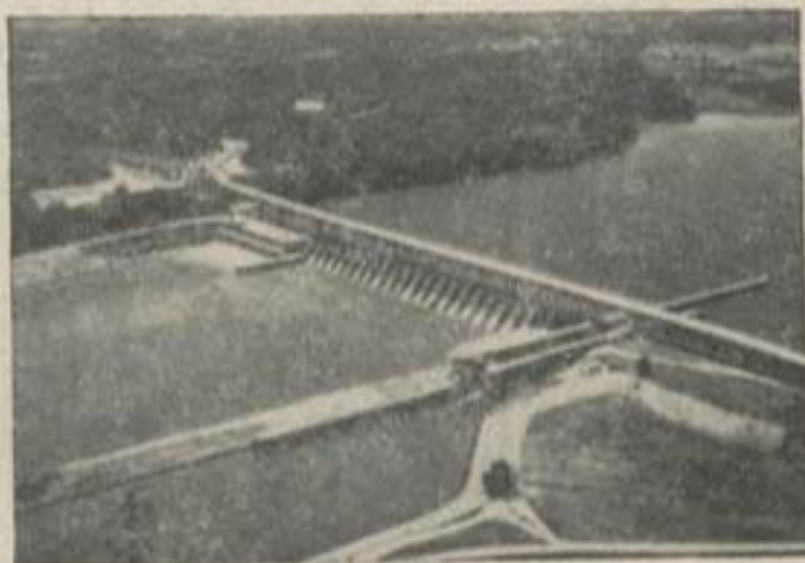
Рис. 15. Общий вид гидроузла Уотс-Бар.
